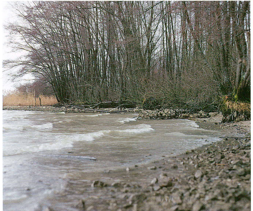
Fig. 11 Erosion de la rive sud du lac de Neuchâtel: site de Font/Sous l'Epenex avant sa protection
