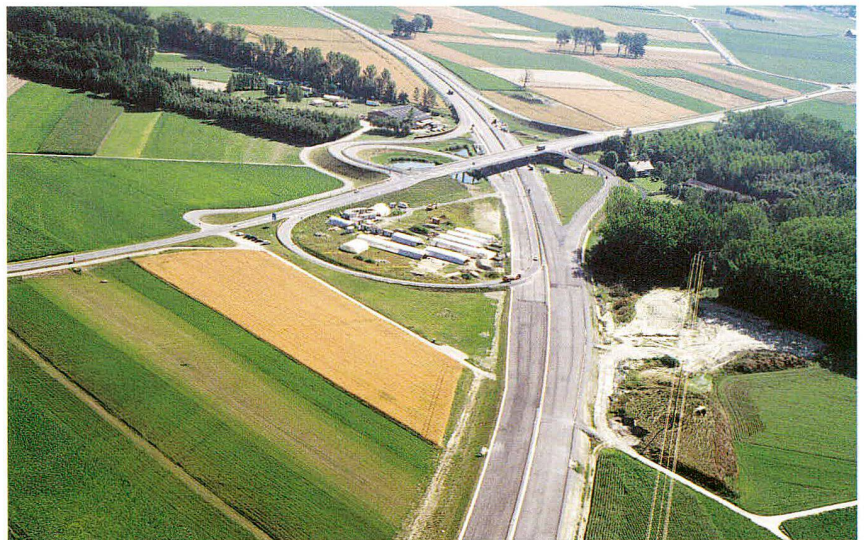
Fig. 1 Vue aérienne du site
