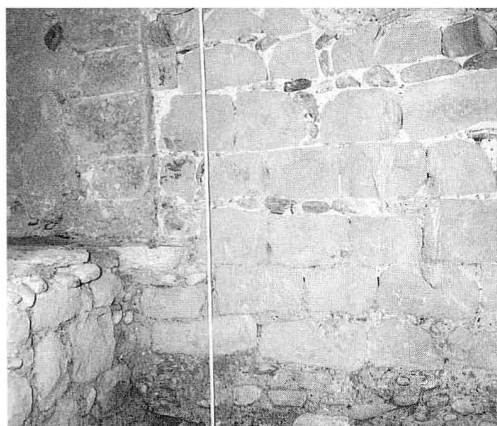
Abb. 8 Mauerwerk des 13. Jahrhunderts, Westmauer des westlichen Kellers
