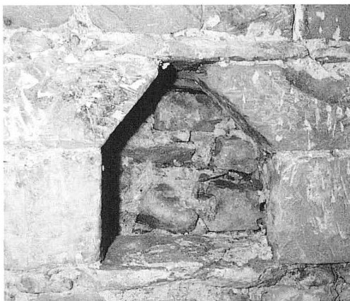
Abb. 7 Leuchternische im Kellerhals aus dem 13. Jahrhundert
