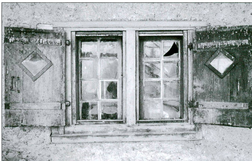
Fig. / Abb. 7 Rez-de-chaussée sud, fenêtre géminée, cadres de bois (1797/1798) Südliches Erdgeschoss: Doppelfenster mit Holzrahmen (1797/1798)
