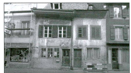
Abb. 16 Fassade zur Strassenseite
