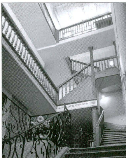
Fig. 10 Vue générale de la cage d'escalier
