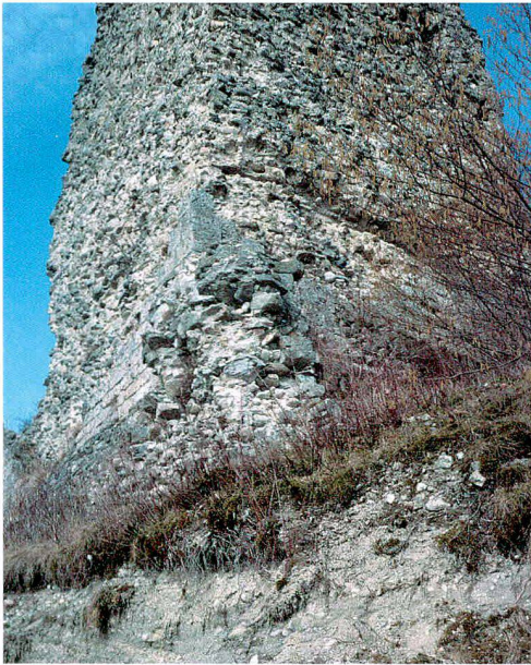
Fig. / Abb. 11 L'érosion du flanc sud en 2003 Die Erosion an der Südflanke im Jahr 2003
