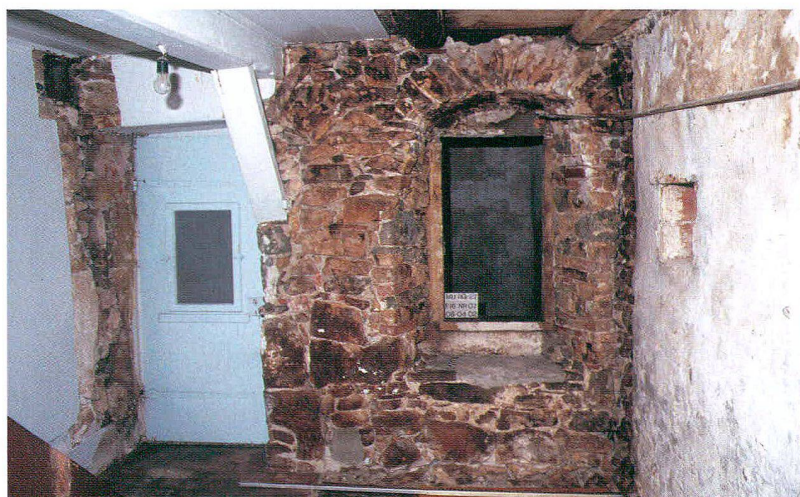
Abb. / Fig. 3 Kernbau-Nordmauer mit den Entlastungsbögen der zwei originalen Öffnungen, Blick nach Norden Vue du mur nord depuis l'intérieur, avec les arcs de décharge des deux ouvertures originales
