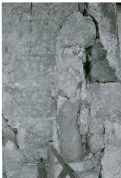
Fig. 11 Fribourg/Stalden 16. Restes de la fenêtre primitive du deuxième étage (première moitié du XIII e siècle)
