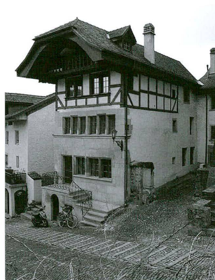
Fig. 7 Fribourg/Court-Chemin 20. Vue générale avant les travaux
