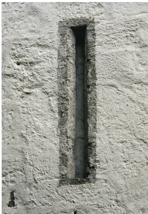
Fig. / Abb. 10 Corps de logis, façade sud, archère de la première phase Corps de logis, Südfassade, Schiesscharte der ersten Bauphase
