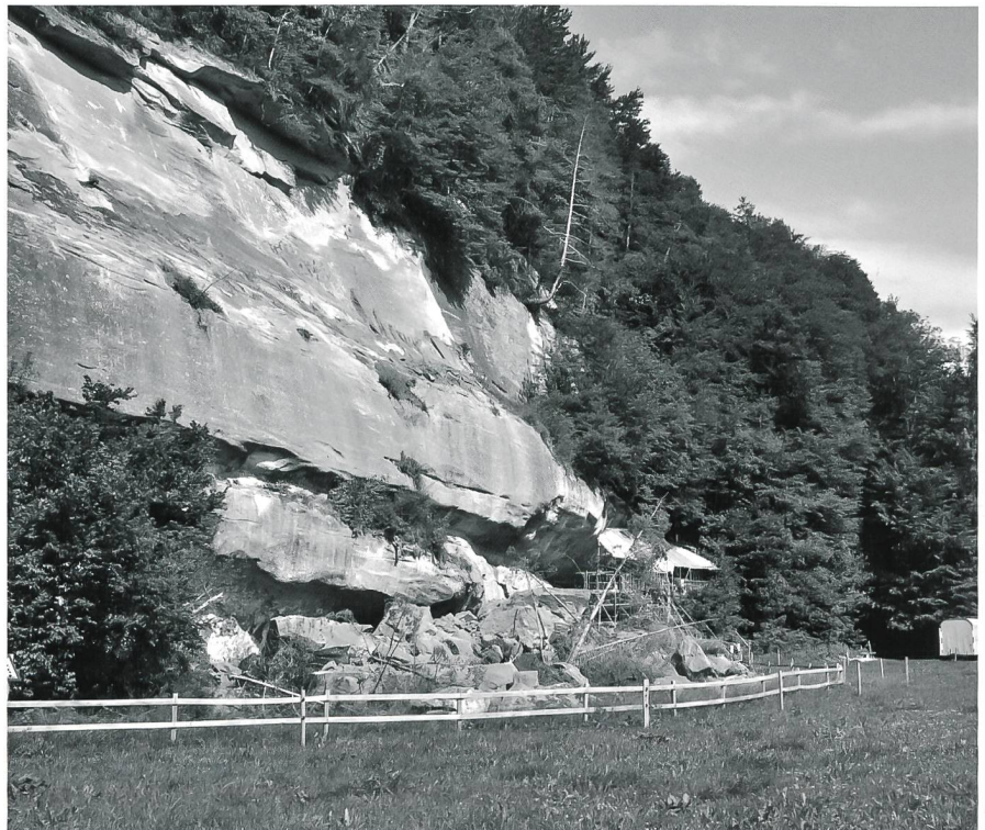
Fig. 1 Arconciel/La Souche, vue du site avec, au premier plan, le pan de falaise effondré en 2012
