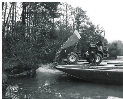
Fig. 3 Système de transport et de déchargement des galets mis en œuvre par l'armée
