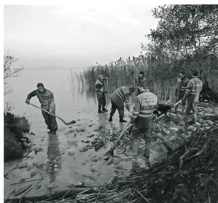
Fig. 5 Répartition des galets dans la zone sud-ouest de la station par les hommes de la protection civile
