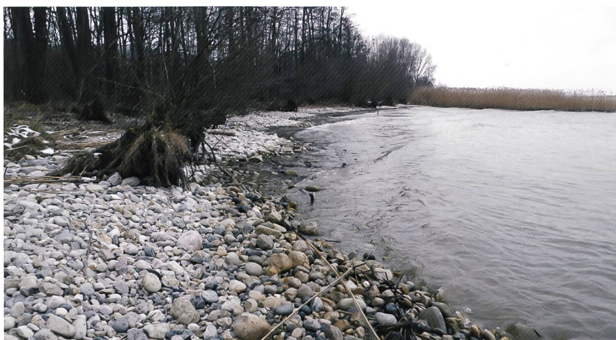
Fig. 6 Etat des berges à la fin de l'intervention
