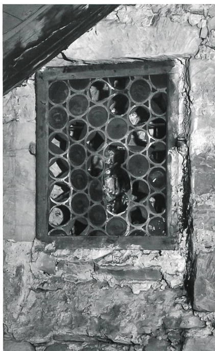
Fig. 11 Fribourg/Rue des Chanoines 9. Fenêtre à vitrage de cives du pignon oriental, XVI e ou XVII e siècle
