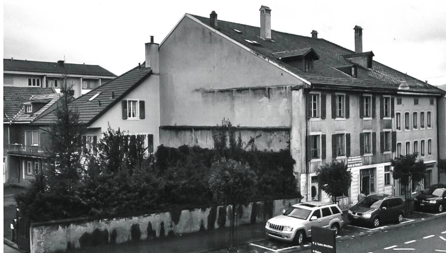
Fig. 5 Bulle/Grand-Rue 61. Vue générale du sud-est avant les travaux en 2011; les ressauts marquant les étages sont clairement visibles sur le mur sud
