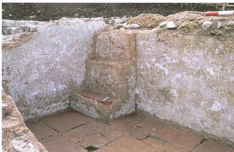
Fig. 3 Vue du bassin L 1.2 depuis le nord.
