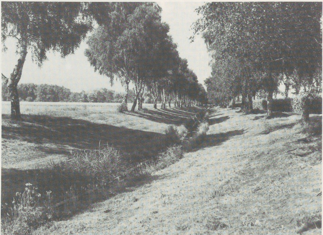
Abb. 5 Der Kanal ist in der Orbe-Ebene erhalten geblieben. Er dient als Sammelkanal des Entwässerungssystems.
