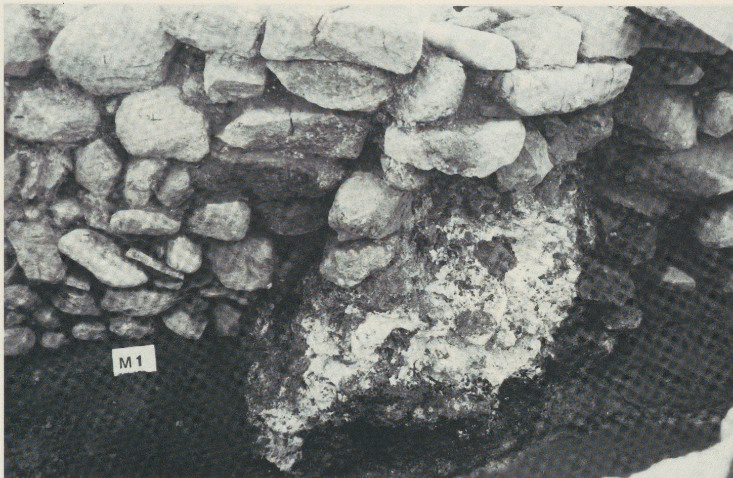
Fig. 145. Alandier du four à chaux (st.150), vue nord.
