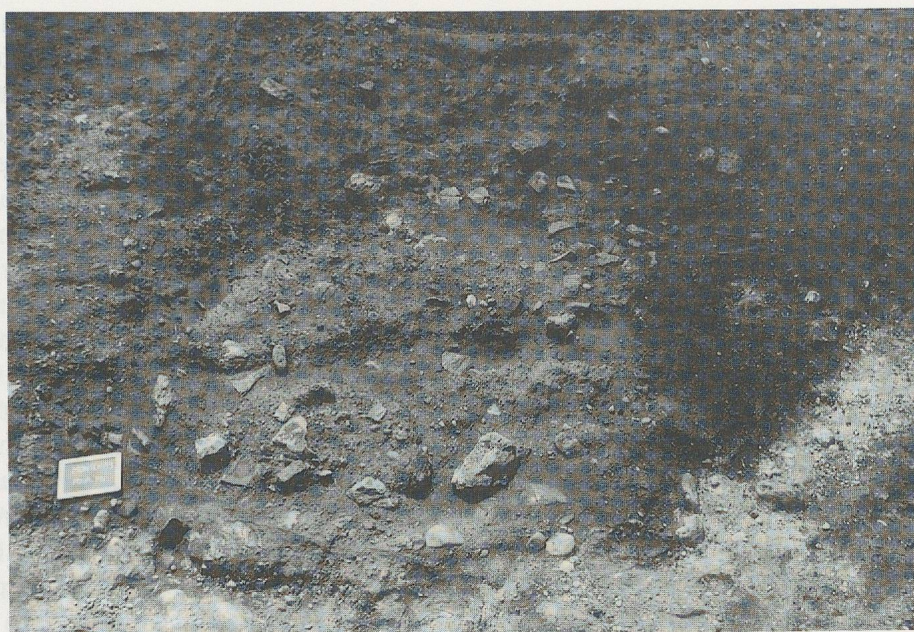
Fig. 26 Bas-fourneau Vc (ex FourMI) vu du nord: les pierres provenant de la voûte sont essentiellement présentes à l'intérieur du bas-fourneau (Photo MHA VD).
