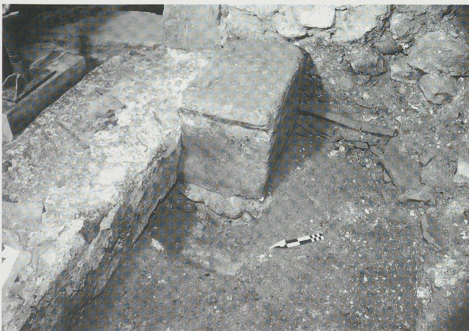
Fig. 15d. Base de molasse (st.423) accolée au mur M178.
