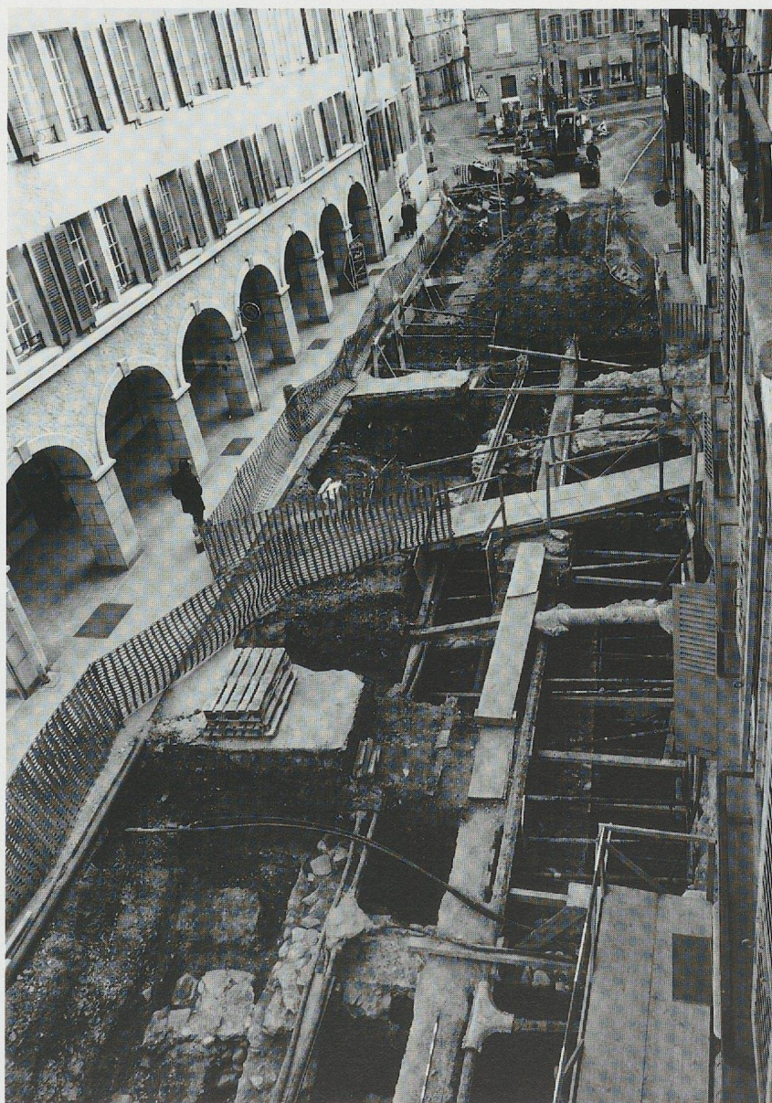
Fig. 4. Grand'Rue 1989: dégagement de l'extrémité de la branche sud du cryptoportique.
