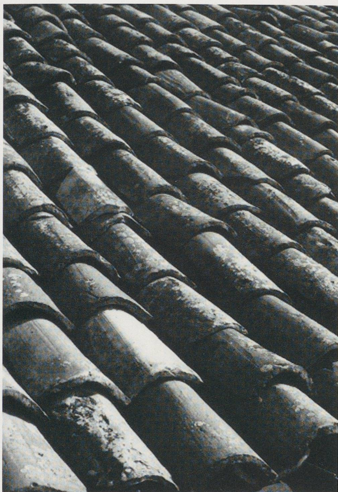
Fig. 155. Lutry, rue de la Tour 3. Détail de la couverture de tuiles canal.
