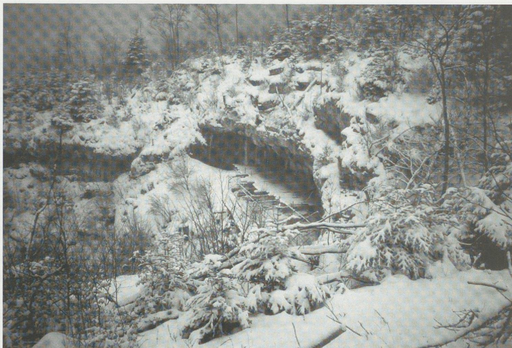
Fig. 11. Protection hivernale du chantier.
