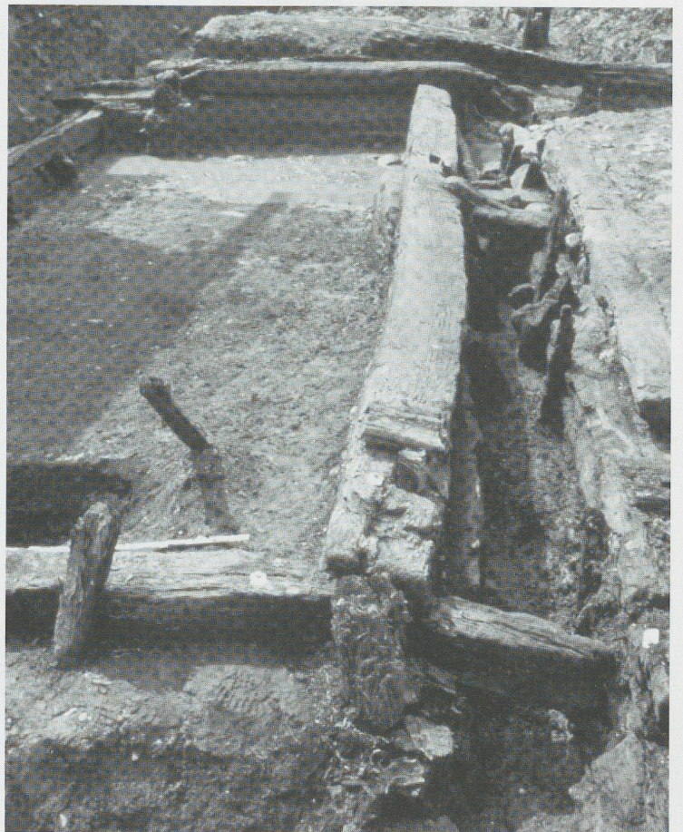
Abb. 17: Schwellbalken der Portikuskonstruktion mit Eckverbindung (im Vordergrund). Entlang des Schwellbalkens verläuft der hölzerne Portikuskanal. Links oben ist der Schwellbalken der strassenseitigen Hauswand zu erkennen (Parzelle 12, Siedlungshorizont I.4-5, 30/33 bis 48/51 n. Chr.).
