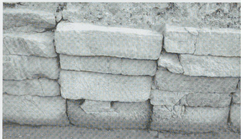
Fig. 2: Parement en grès rose taillé du Fossé des Pandours. (Cliché S. Fichtl).
