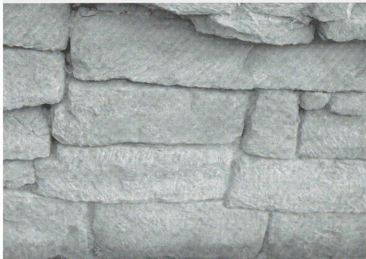
Fig. 3: Détail du parement en grès rose taillé du Fossé des Pandours. (Cliché S. Fichtl).
