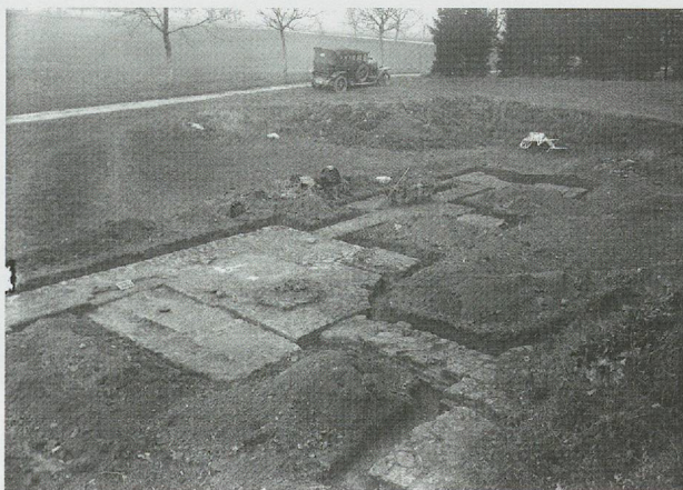
Abb. 21 Freilegung der Fundamente der NE-Halle (1927).
