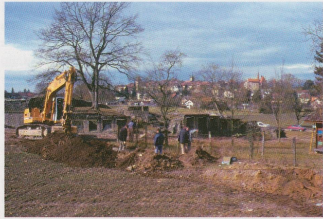
Abb. 30 TRA 1999.1, Aushub Bagger Sondierung S25.
