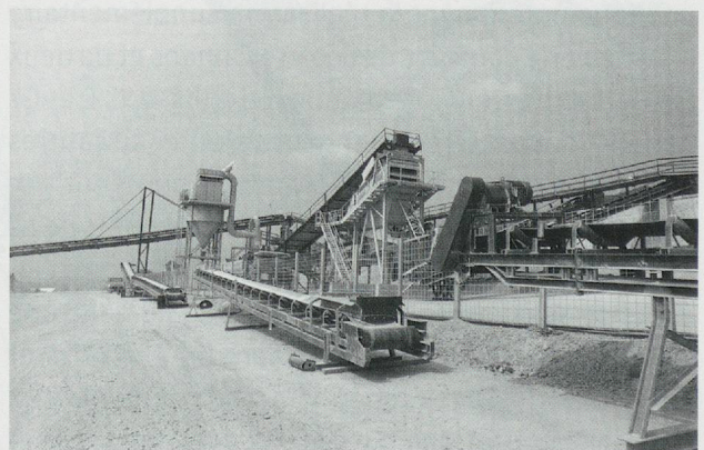
Fig. 5. Vue de la zone de concassage, localisation fig. 2, 16.
