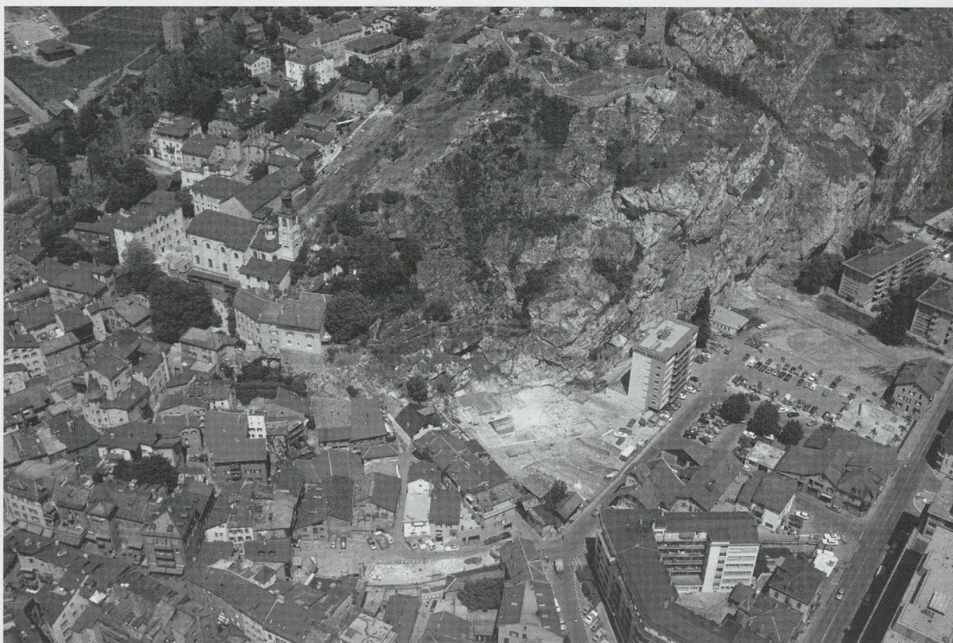
Figure 1. Vue aérienne du centre de la ville de Sion avec le rocher de Valère et le lieu-dit Sous-le-Scex où l'on distingue le chantier archéologique.
