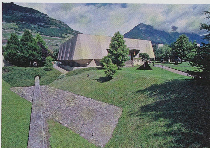
▼ Fig. 10 — Martigny, Téménos, area sacra . Le mur d'enceinte sud-ouest du téménos coupant une structure en pierres sèches plus ancienne. À l'arrière plan, la Fondation Pierre Gianadda, du sud-est (© Archéologie cantonale, Martigny, photo François Wiblé).
