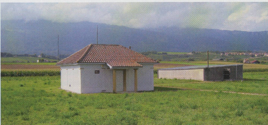
Fig. 8 — Orbe/Boscéaz. Pavillon de 1920 et baraque de 1993: deux solutions pour abriter les mosaïques d'une vaste et riche demeure campagnarde, conservées in situ (photo Ph. Bridel).
