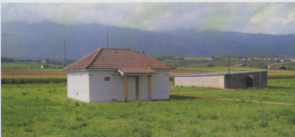
Fig. 8 — Orbe/Boscéaz. Pavillon de 1920 et baraque de 1993 : deux solutions pour abriter les mosaïques d'une vaste et riche demeure campagnarde, conservées in situ (photo Ph. Bridel).
