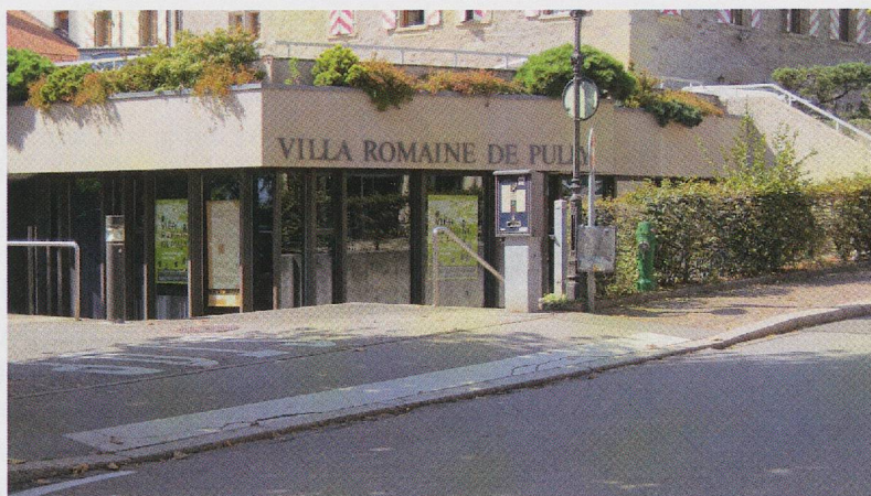
Fig. 12 — Pully. Le bâtiment abritant les vestiges du portique absidé, orné d'une fresque, qui donnait sur le jardin de cette belle résidence des bords du Léman (photo Ph. Bridel).
