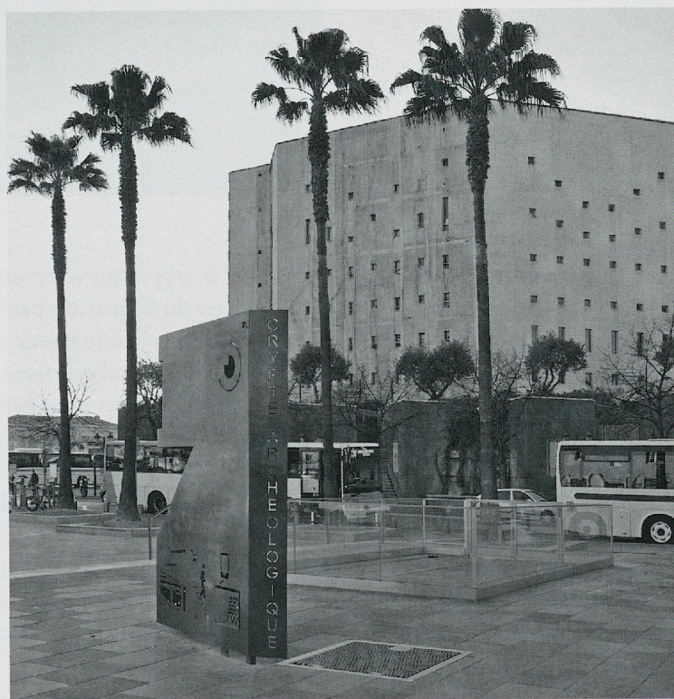
Fig. 4 — Le totem et l'accès à la crypte avant la mise en place de l'ascenseur (photo M. Bouiron/SAVN).
