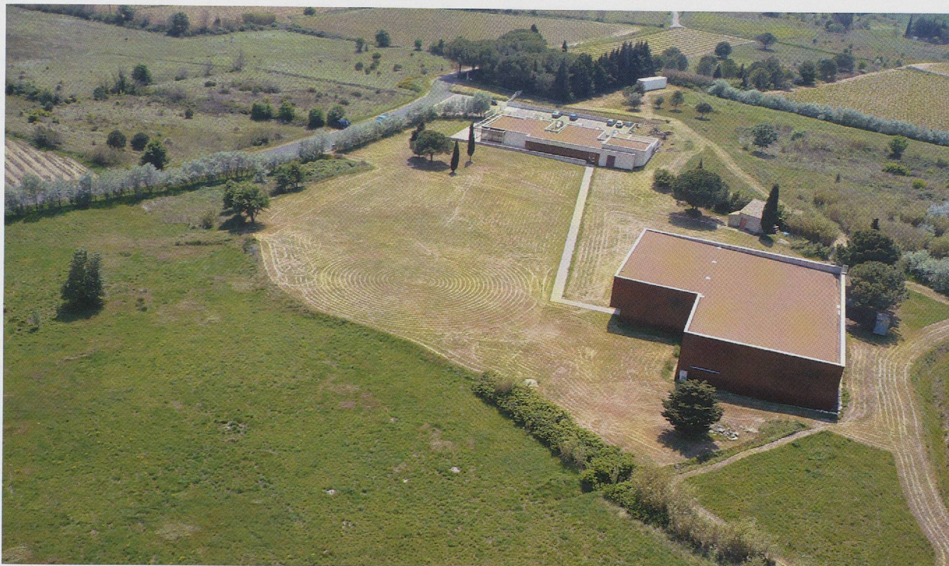
Fig. 4 — Le musée de site aujourd'hui. Dans un espace foncier public correspondant à l'emprise du site archéologique, au premier plan le bâtiment de protection de la résidence de l'Antiquité tardive; en arrière-plan, le bâtiment d'accueil (cliché Selim Benalioua).
