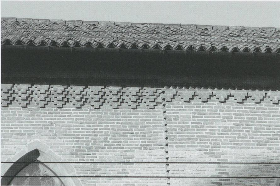
Fig. 100. L'église Saint-Gervais à Genève, de 1436 à 1449 environ. Détail de la rupture du décor de la corniche en brique au sud de la nef, ouvrage en partie de Pierre Mascrot, d'Aglié en Piémont, maçon-carronnier et paroissien (photo MG, 2009).
