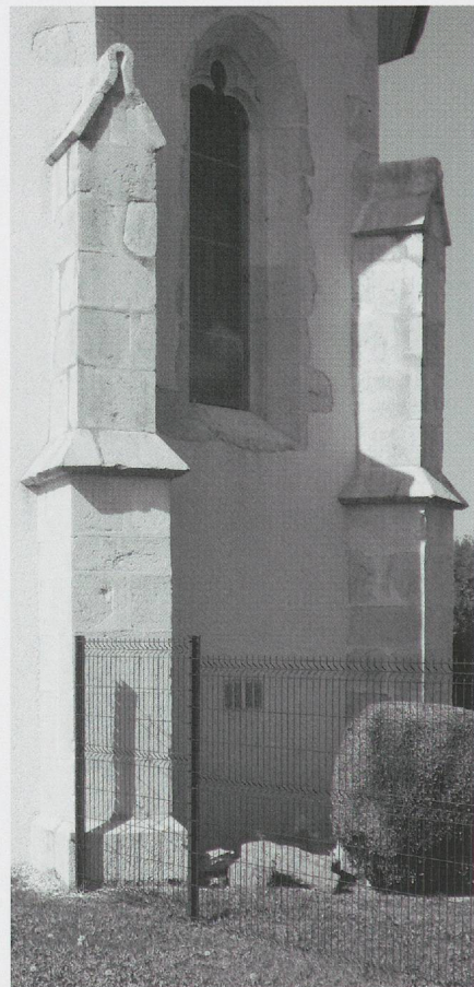
Fig. 189. L'église paroissiale d'Arenthon en Faucigny (peu avant 1516): deux des contreforts en bâtière à pli faîtière au chevet du chœur (photo MG, 2013).
