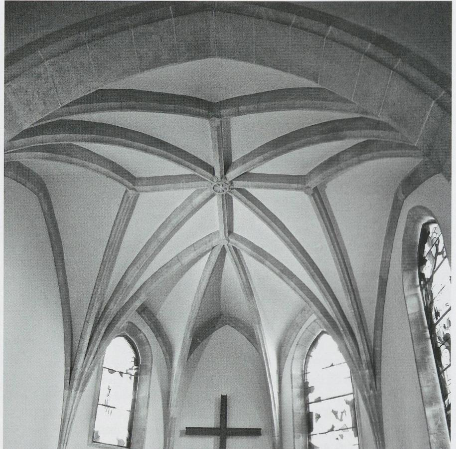
Fig. 657 b. L'église paroissiale de Cernier: le chœur gothique flamboyant, du début du XVI<sup>e</sup> siècle, «en étoile» dans la travée droite prolongée par deux nervures dans l'abside (photo MG, 2010).
