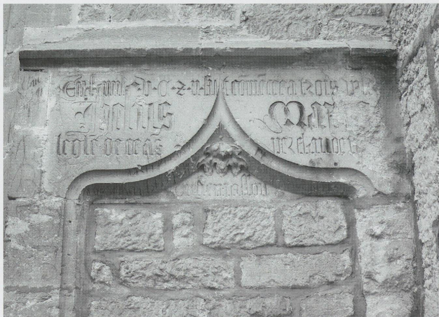
Fig. 608. L'église Saint-Laurent de Mouthier-Hautepierre, dont les trois vaisseaux de 1502 sont l'œuvre du maçon-architecte Claude d'Usier. L'inscription de la porte latérale (photo MG, 2010).
