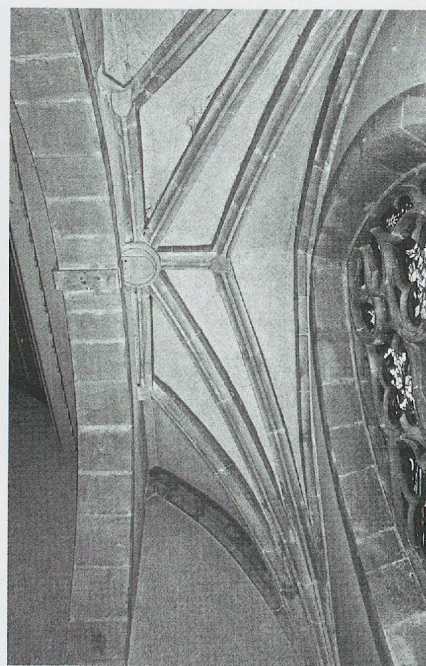
Fig. 671. La chapelle Gaudet à l'église de Saint-Blaise. La fenêtre à remplage flamboyant du 1 er quart du XVI e siècle (photo OPMS, Neuchâtel).
