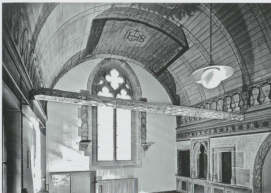
Fig. 666. La chapelle du château de Neuchâtel (1447/1449-1453). Vue de l'intérieur, avec son couvrement en berceau lambrissé peint vers 1680 (photo Fernand Perret, MAH, Neuchâtel, I, 1955).
