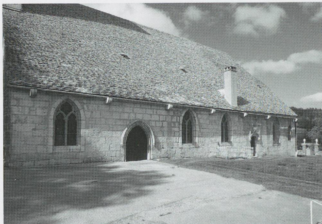
Fig. 600. L'église Saint-Georges du Bizot, 1503. La face sud sans contreforts et le toit en lauzes (photo MG, 2011).
