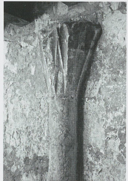
Fig. 678. L'ancienne chapelle gothique de la priorale Saint-Pierre à Môtiers-Travers. Vestige de retombées de nervures en pénétration sur une colonne engagée montrant un recoupement de cavets (photo MG, 2011).
