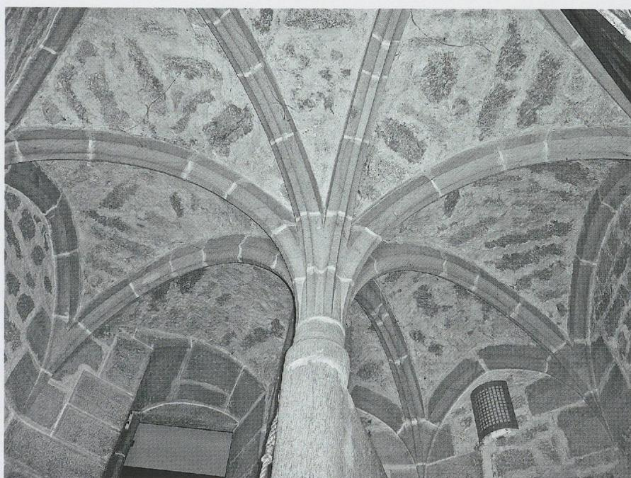
Fig. 682. Le château de Colombier. La voûte d'ogives coiffant l'escalier en vis dans la tour hexagonale de l'entrée principale (photo MG, 2010).
