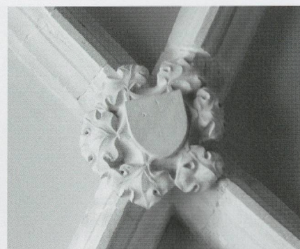
Fig. 616 c. L'église de Sombacour (1493).
