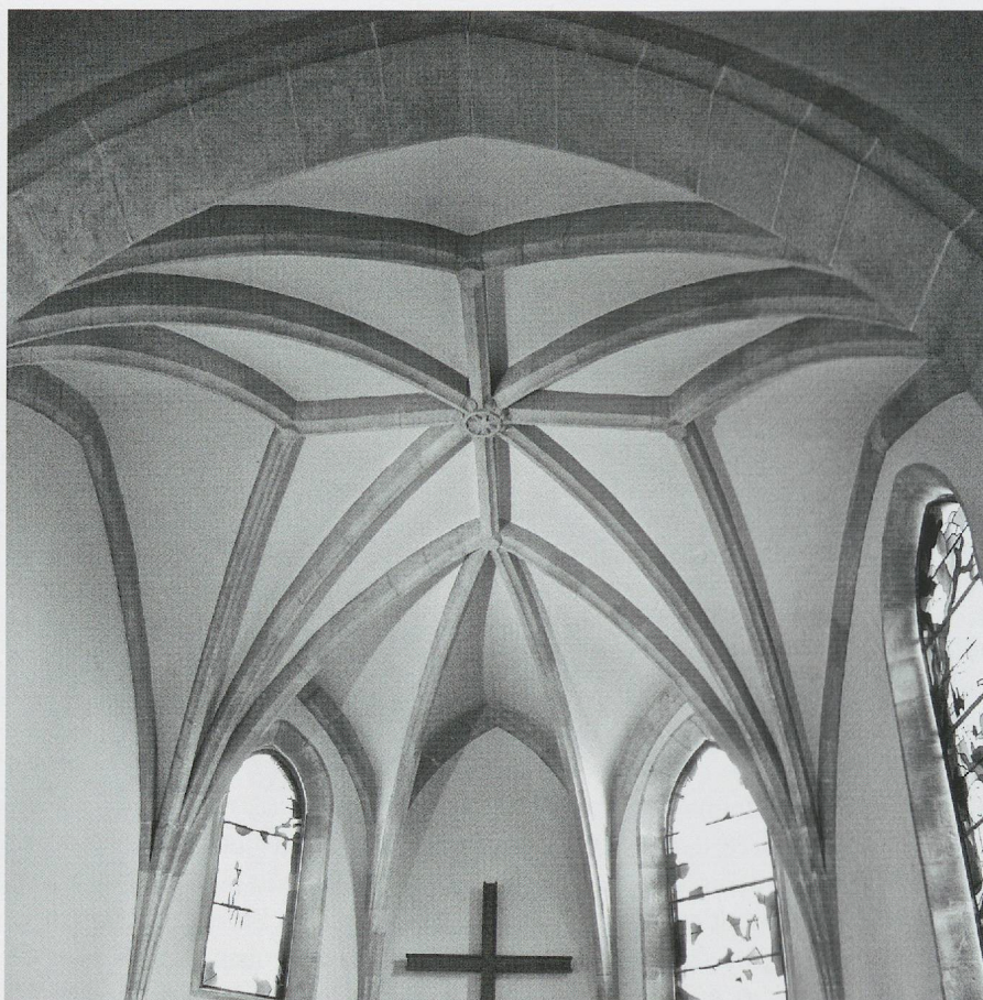
Fig. 657 b. L'église paroissiale de Cernier: le chœur gothique flamboyant, du début du XVI e siècle, «en étoile» dans la travée droite prolongée par deux nervures dans l'abside (photo MG, 2010).
