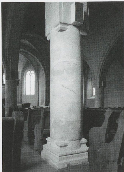
Fig. 628. L'église paroissiale de Môtiers au Val-de-Travers. Un pilier au nord de la nef de 1490, par Pierre Perrenel (photo MG, 2013).
