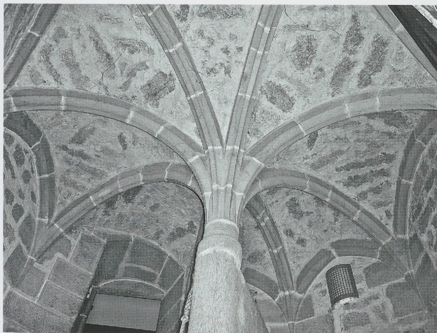
Fig. 682. Le château de Colombier. La voûte d'ogives coiffant l'escalier en vis dans la tour hexagonale de l'entrée principale (photo MG, 2010).
