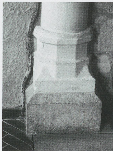
Fig. 711. L'église des Verrières. La base du support sud de la voûte du chœur, 1517 (photo MG, 2009).
