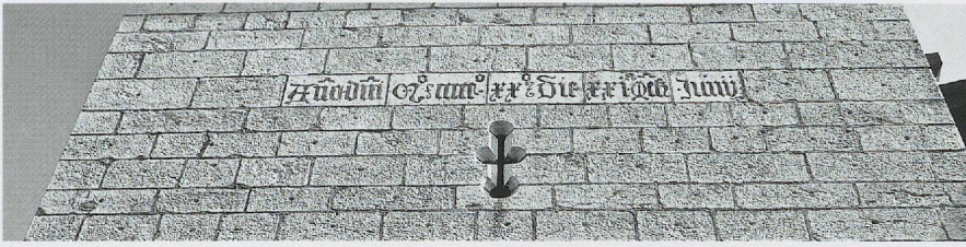
Fig. 703. La tour-beffroi de La Neuveville BE, construite de 1519 et 1520 par Jean Jornod. L'inscription du 1 er étage donnant la date du 21 juin 1520 (photo MG, 2011).
