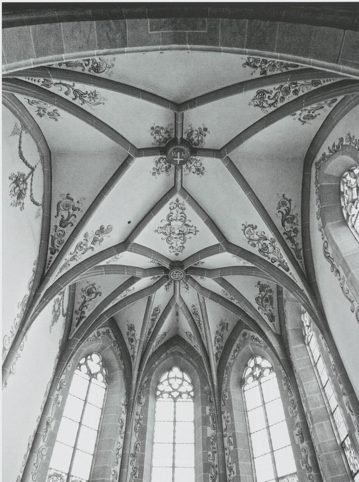
Fig. 762. L'église paroissiale de Gléresse/Ligerz BE. La voûte en étoiles du chœur de 1520/1523 (photo MG, 2011). Voir aussi fig. 723.
