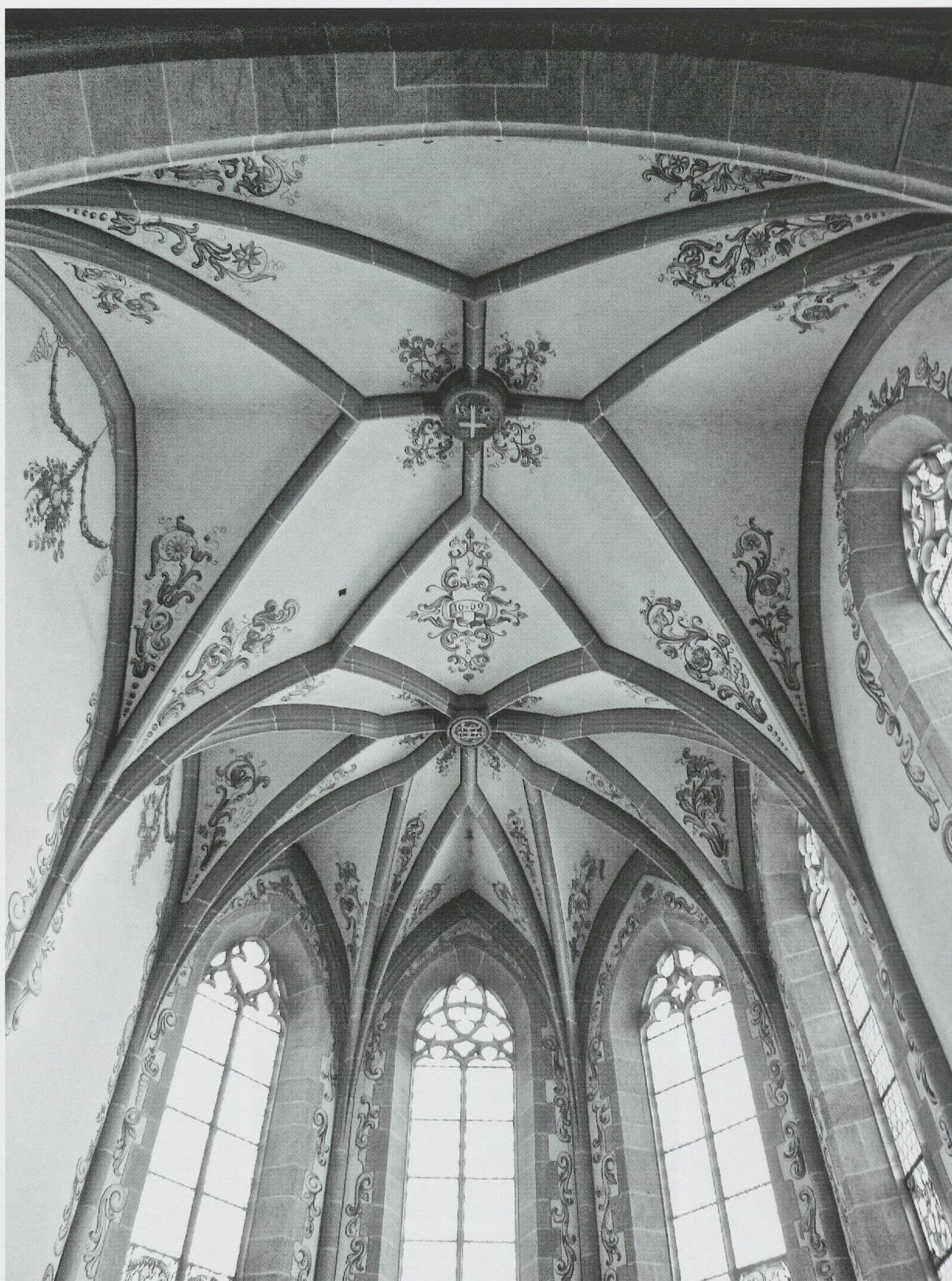
Fig. 762. L'église paroissiale de Gléresse/Ligerz BE. La voûte en étoiles du chœur de 1520/1523 (photo MG, 2011). Voir aussi fig. 723.
