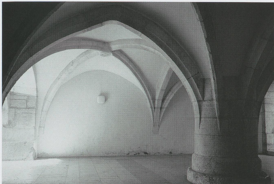
Fig. 774. La halle communale de Saint-Ursanne de 1492, au rez-de-chaussée de la maison de ville. Vue intérieure (photo MG, 2003).
