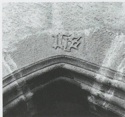
Fig. 795. L'église Saint-Théodule d'Ormont-Dessus (Vers-l'Eglise). Détail de la voûte d'ogives du chœur (photo MG, 1967).
