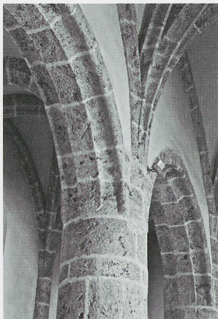
Fig. 828. L'église Saint-Vincent de Montreux. Détail d'arcades au nord de la nef, 1513/1519, attribuable à Pierre Guigoz (photo MG, 2013).
