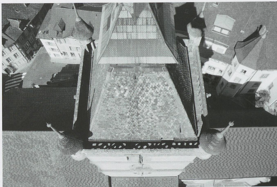
Fig. 920 b. L'église Saint-Laurent d'Estavayer. Le sommet du clocher par Pierre et Jacques Ruffiner (1525), avec ses coursières et ses échauguettes: vue «aérienne» plongeante du sud (photo Daniel de Raemy, 2007).
