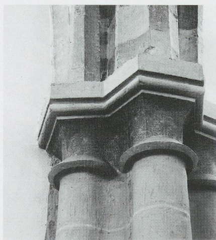
Fig. 933 a. L'église Saint-Théodule de Goumœns-la-Ville. Un pilier composée du chœur, avant 1430: état après la restauration de 1952 (photo MG).
