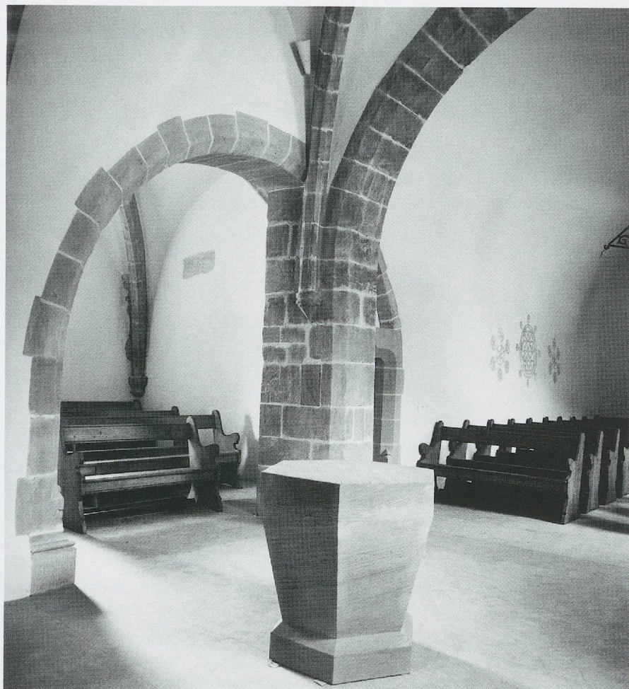
Fig. 934 a. L'église Saint-Maurice de Lavigny. L'entrée de la chapelle Saint-Jean-Baptiste (vers 1460) s'ouvrant derrière le pilier sud de l'arc triomphal (photo Bernard Anderes pour la SHAS).
