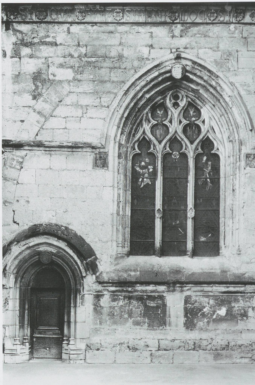
Fig. 969. La cathédrale de Lausanne. Vue extérieure du mur de la grande arcade nord, daté de 1504, fermant l'ancien passage de la «grande travée», encore visible à gauche (photo Claude Bornand, vers 1975).
