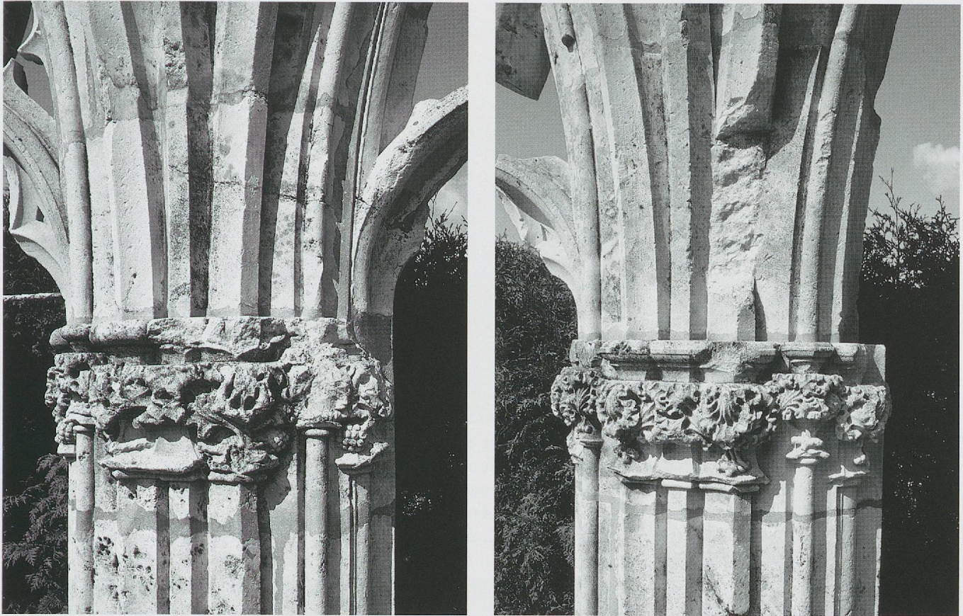
Fig. 1023-1024. L'ancienne abbaye des Prémontrés du Lac de Joux: les deux chapiteaux des piliers d'une arcade du cloître: état après leur déplacement en 1969-1971 (photos MG, 1985).
