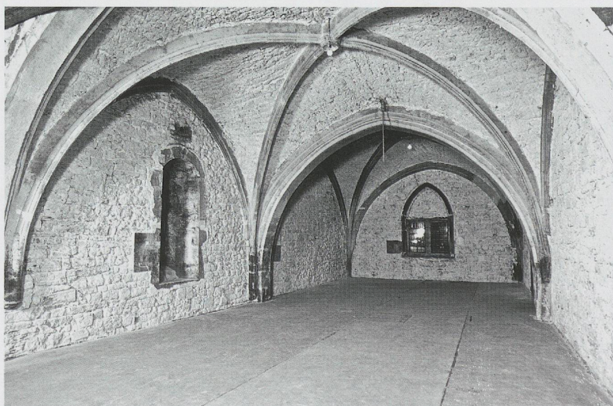
Fig. 1002. L'église bénédictine Saint-Pierre de Môtiers-Travers NE. Vue de la partie haute du chœur (avant 1512?) vers l'est, durant les travaux commencés en 1995 (photo OPMS, Neuchâtel).
