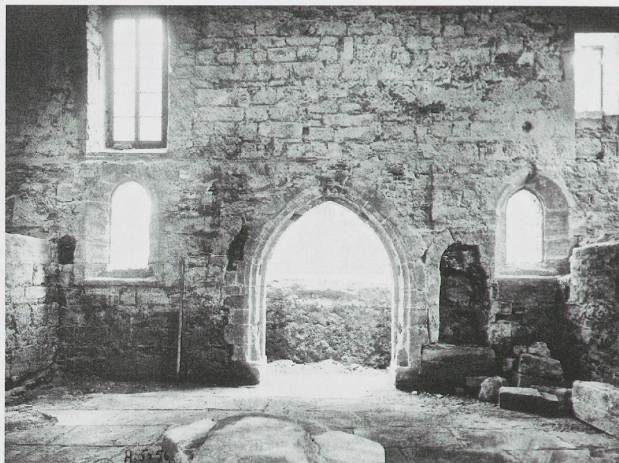
Fig. 1034 a. L'abbaye cistercienne de Montheron (Lausanne): l'ancienne salle capitulaire des XIII e /XVI e siècle, vue vers l'est lors des travaux de 1928 (photo André Kern).
