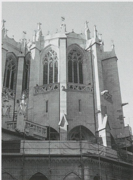
Fig. 1046. L'église Saint-Nizier à Lyon. Le chevet, où se voit le passage du rayonnant au flamboyant (photo MG, 2000).
