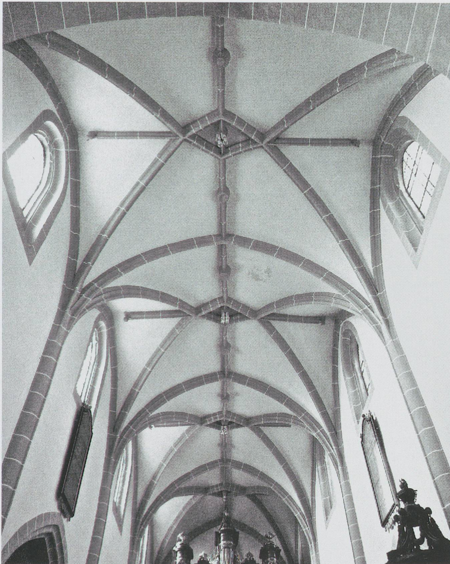
Fig. 1069. L'église Saint-Martin de Vevey. Les voûtes de la nef (vers 1530), par François de Curtine, bourgeois de Genève (photo MG, 2011).
