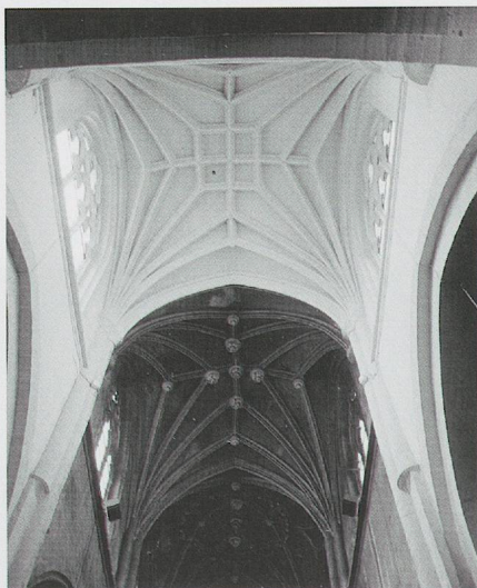
Fig. 1061 b. L'église Notre-Dame- des-Marais à Villefranche-sur-Saône. La première voûte orientale et sans doute la plus ancienne, du début du XVI e siècle? (photo MG, 2000).
