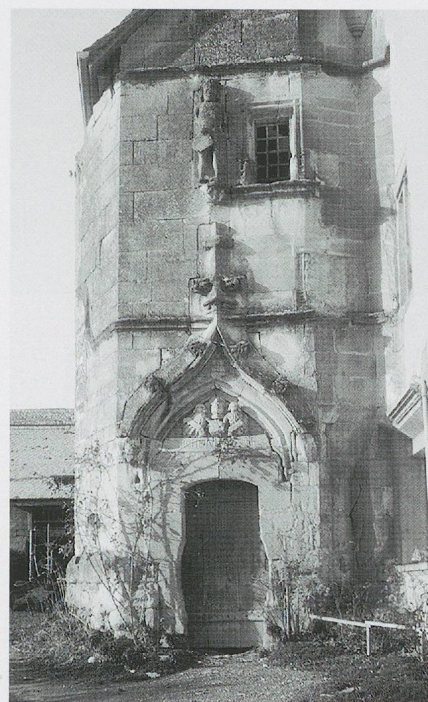
Fig. 1110. Le château de Colombier-sur-Morges VD, du début du XVI e siècle. Le portail de la tour d'escaliers, avec sa porte rénoverée (photo MG, 1975).
