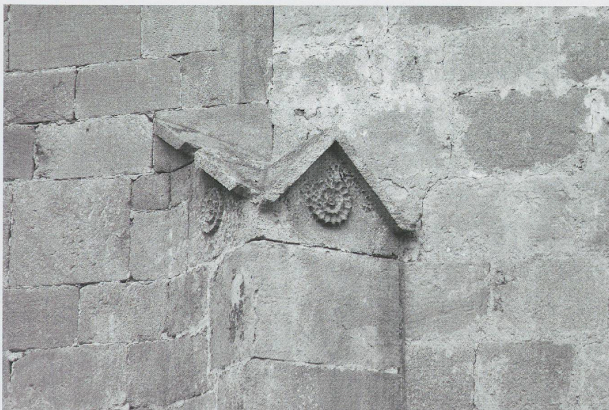
Fig. 1102 b. L'église d'Oye-et-Palet, près de Pontarlier (Doubs). Le contrefort sud-est de la nef, noyé dans l'agrandissement du chœur (photo MG, 2011).
