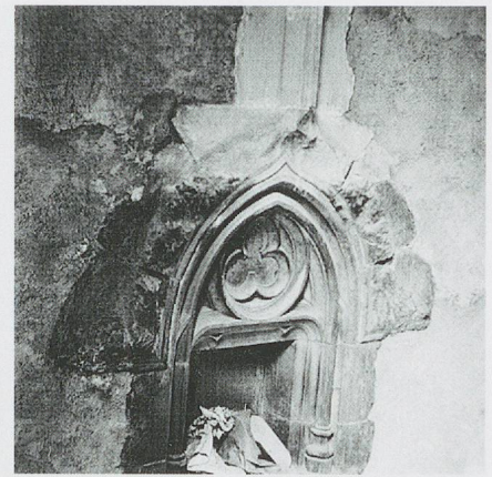
Fig. 1141. La maladière de Vège à la Madeleine (Cornier), en Faucigny. Le tabernacle mural du chœur, lors des travaux (photo MG, vers 1970).
