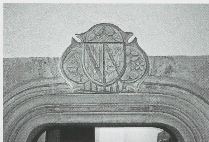
Fig. 1112. L'église de la chartreuse du Reposoir, en Faucigny. La porte de la chapelle du château de Planaz (Desingy) en Genevois, de 1520 environ, remontée (photo MG, 2013).
