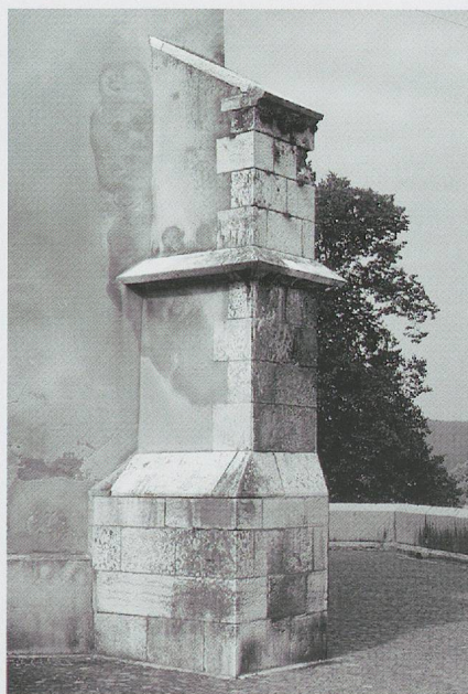
Fig. 1098. L'église des Cordeliers de Myans (Savoie). Chevet des deux églises superposées, achevées vers 1498, avec ses immenses contreforts «genevois» (photo MG, 1995).
