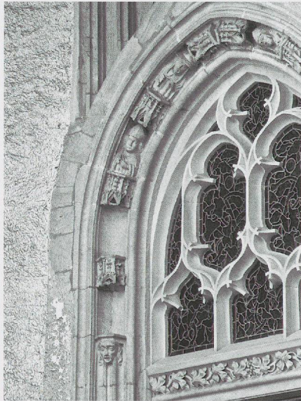
Fig. 1102 c. L'église Saint-Benoît de Bienne. Détail du portail à voussures sculptées des bustes des Pères de l'Eglise (photo MG, 2011). Le remplage est moderne.
