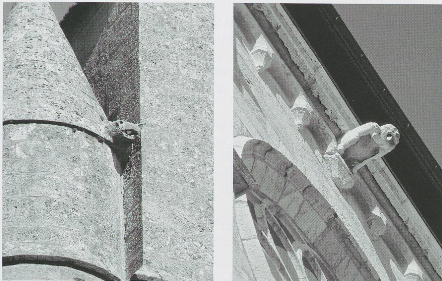
Fig. 1127. L'église de Saint-Blaise NE (1516). La gargouille ouest du cône coiffant l'escalier du clocher (photo MG, 2009).
