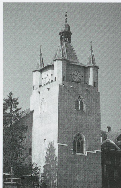
Fig. 886 a. Notre-Dame d'Orbe. Le clocher, ancienne tour d'enceinte, remaniée au début du XV e siècle, et son couronnement à coursières en retrait avec ses tourelles attestées en 1507 (photo MG, vers 1980).
