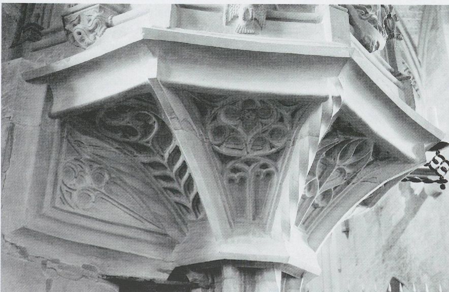
Fig. 882. L'église Notre-Dame de Romont. La chaire de 1520, dont Mermet Forand et Etienne de Leydevant ont fourni le bâti et sans doute l'encorbellement à fenestres aveugles (photo MG, 2012).
