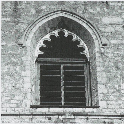
Fig. 887. L'église Saint-Martin de Vevey. La baie sud de l'étage du beffroi avec son exceptionnel intrados polylobé, de 1511 environ (photo MG, 1970).
