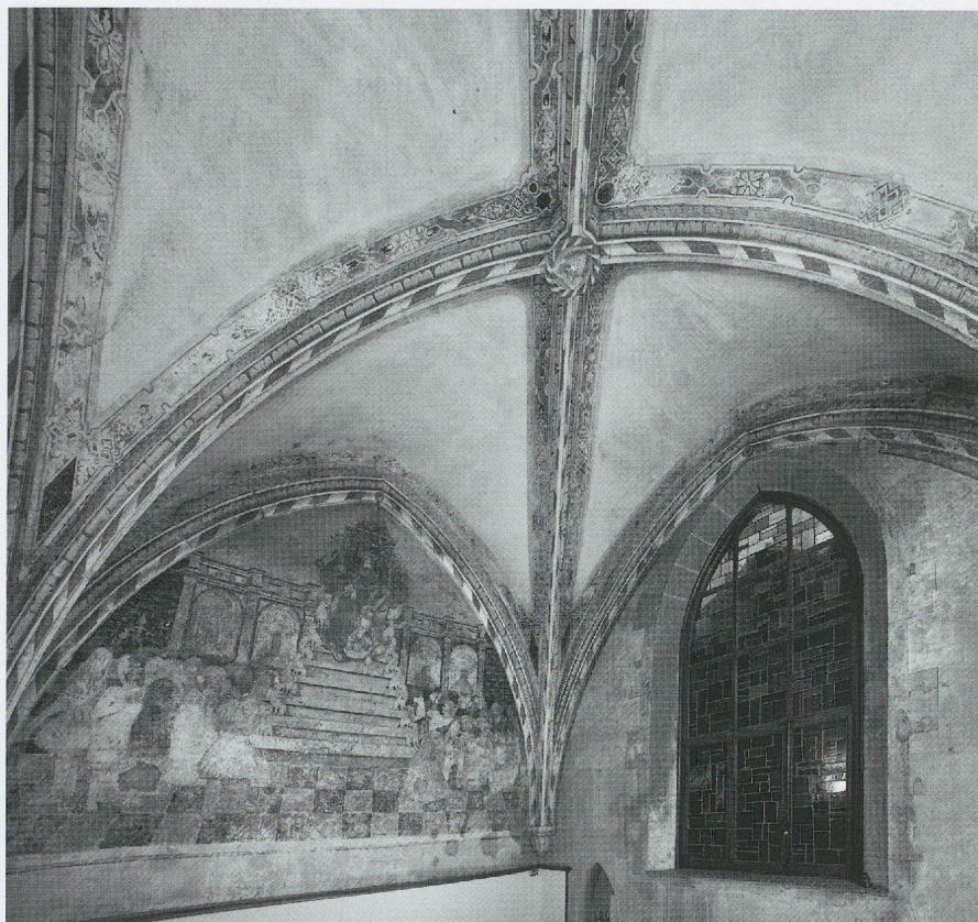
Fig. 889. La chapelle Saint-Antoine et Saint-Jean-Baptiste de l'hôpital de Cully par Antoine Dupuis, de Moudon (1515-1516). La voûte d'ogive avec la peinture du jugement de Salomon de la fin du XVI e siècle (photo Claude Bornand, 2014).
