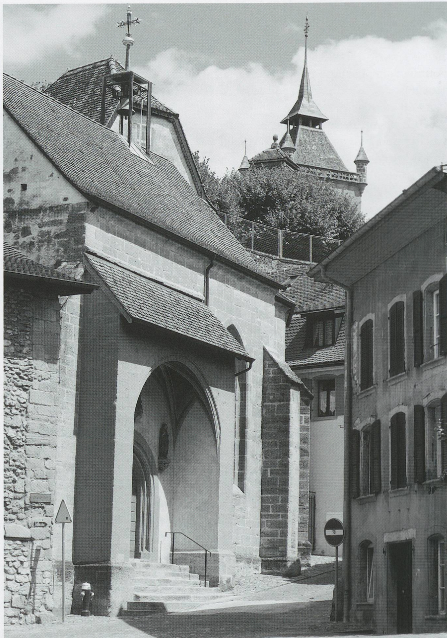
Fig. 871. La chapelle Sainte-Anne de Rive à Estavayer, par François Moschoz, 1488-1489. Vue de l'ouest: seules les faces visibles, au sud et en partie au chevet, offrent un parement de molasse bien appareillé, toutes à la même hauteur et couronnées d'une corniche en cavet (photo MG, 2012).
