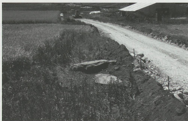
Fig. 130. Les deux premières pierres découvertes (824 la plus grosse et 825 la plus petite), déposées par le bulldozer au bord de la piste de chantier.
