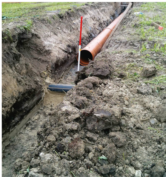
Fig. 187. Eclépens-Le Marais. Tranchée creusée dans les niveaux de tourbe.
