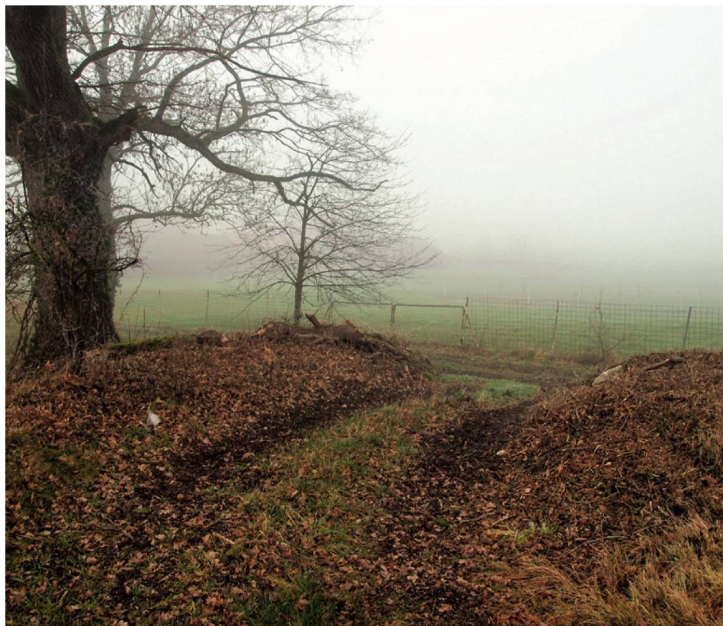
672 Die Kurtine des Teilstückes T3–T4_M1 wird von einem modernen Weg gekreuzt, nördlich davon steht ein Wallnussbaum direkt auf dem Mauerwerk der Kurtine.
