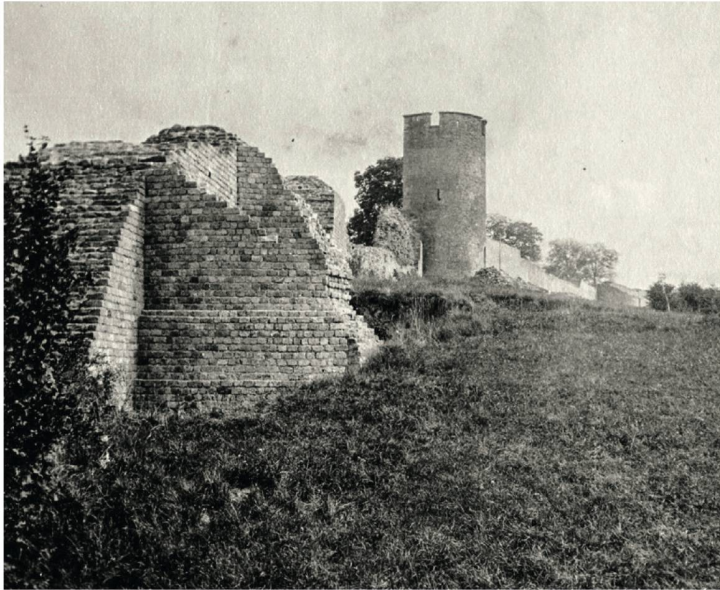
682 Ansicht des restaurierten Mauerwerks von T3 aus Norden. Der kraterartige Einschnitt an der Nordseite resultiert aus den Grabungen des frühen 20. Jh. (1917).
