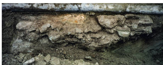
932 Erhaltener Fundamentrest des Teilstückes T55–T56_M1. Innerhalb sind nahezu ausschliesslich Muschelsandsteine verbaut (Ausgrabung 1999.06).
