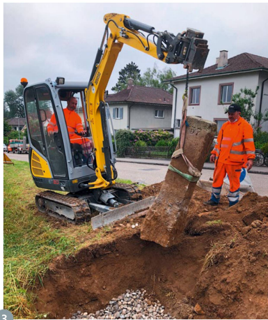
Abbildungen 3 und 4: Ein Bagger hebt und setzt den 400 kg schweren Stein zurück – das Richten des Steins geschieht zu Dritt. (© P. Reimann)
