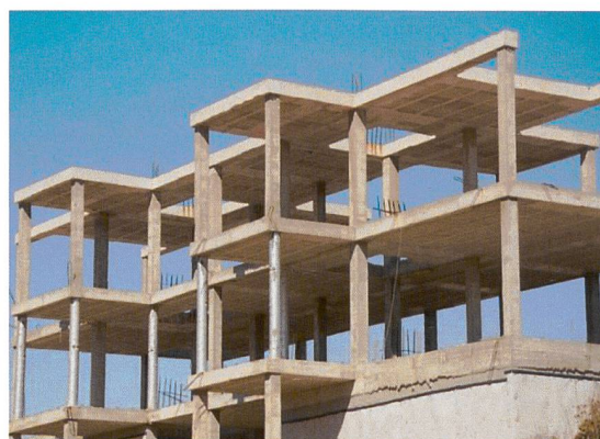
Figure 8: parties communes – éléments statiques d'un bâtiment (piliers porteurs, planchers et plafonds, toit, etc.).
