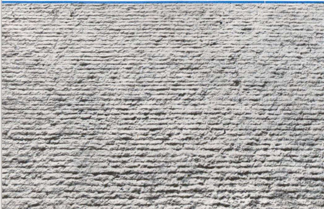
Die Oberfläche einer Betonstrasse in der Photographie: diese zeigt, dass, dank unseres Spezialverfahrens, ihre Oberfläche rauh u. doch eben wird: das macht die Betonstrasse griffig und gleitsicher – scharfheben sich nachts zudem die Hindernisse von ihr ab.
