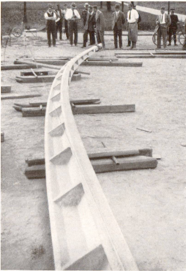
Abb. 2. Belastungsprobe eines Kisse-Stahlbeton-Mastes — grosse Durchbiegung beachten
