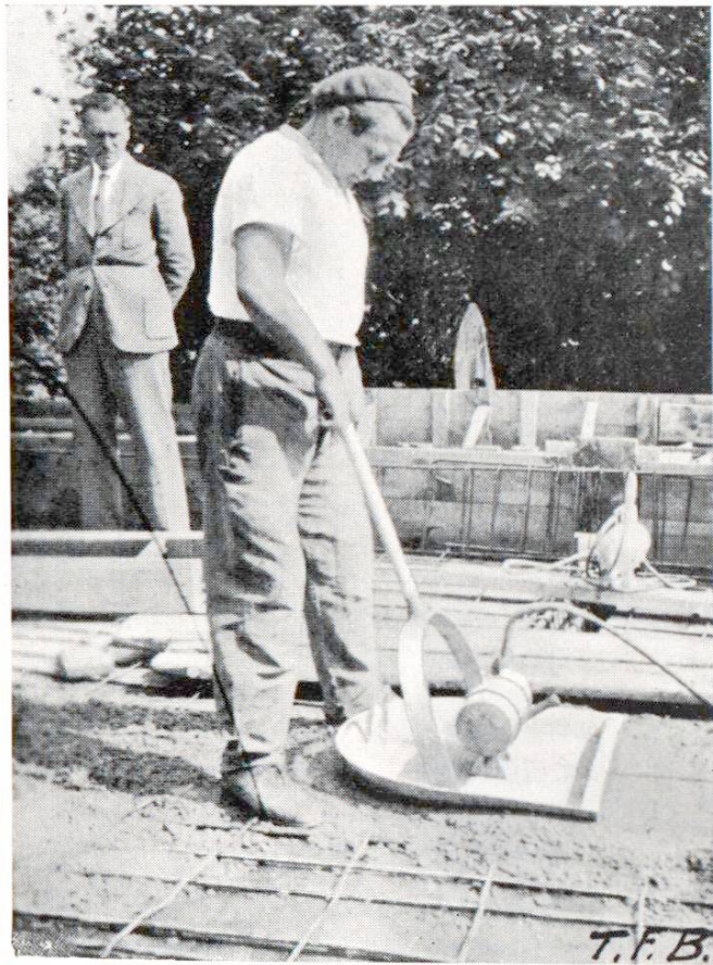
Abb. 3 Oberflächenvibration mit Vibrierschaufel
