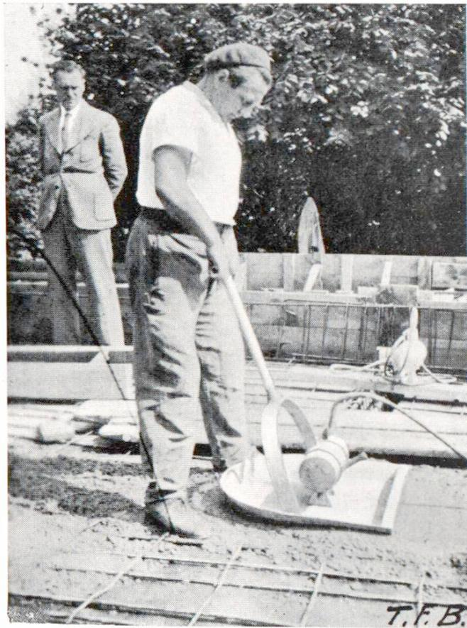
Abb. 3 **Oberflächenvibration** mit Vibrierschaufel
